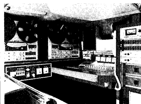
Audio-Inneneinrichtung (v.l.n.r. unten): Netzta- bleau, Mischpult 269, Rack mit Limiter, Jackfield, Verstärker, Sender. (v.l.n.r. oben) PR 99 Aufnahmegeräte, Klimaanlage, Lautsprecher, TV-Monitor, Kontrollempfänger.
